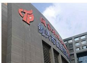
铝塑板外墙翻新
